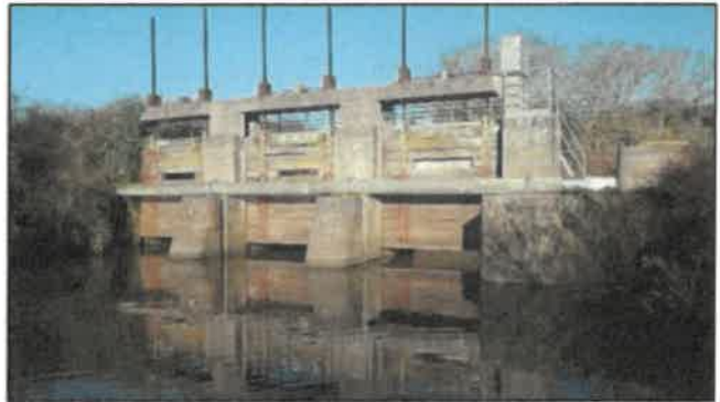
Vue depuis l'aval
