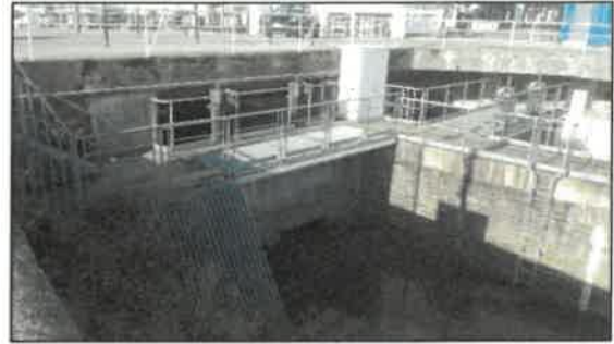
Vue depuis l'aval de la vanne
